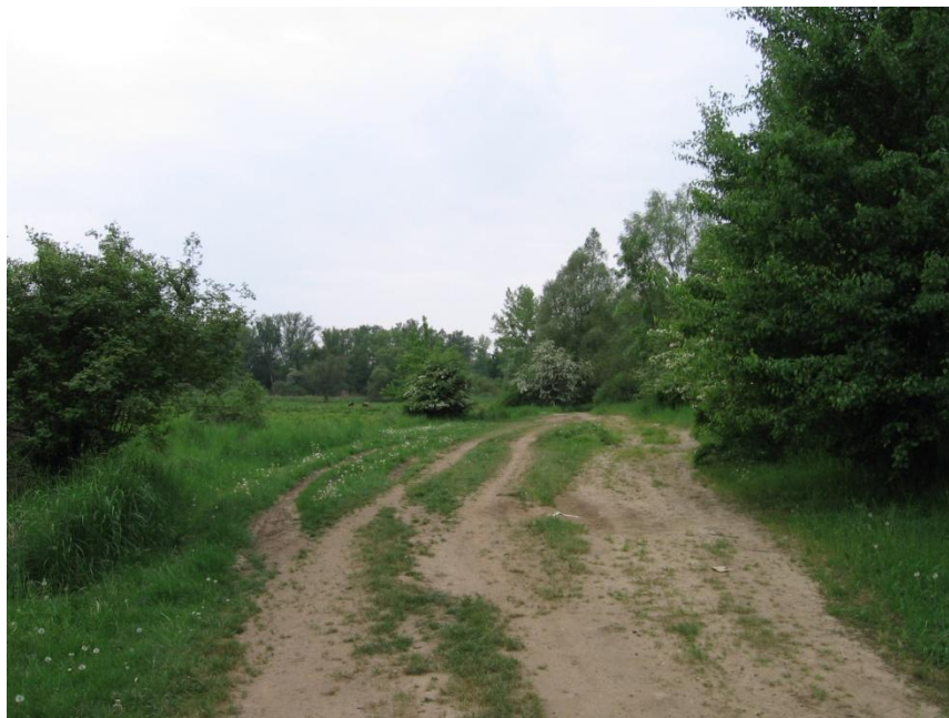
3. Koleiny i zagłębienia w nawierzchni gruntowej, które w okresie jesienno-wiosennym, szczególnie po obfitych opadach powodują że droga jest słabo przejezdna.
