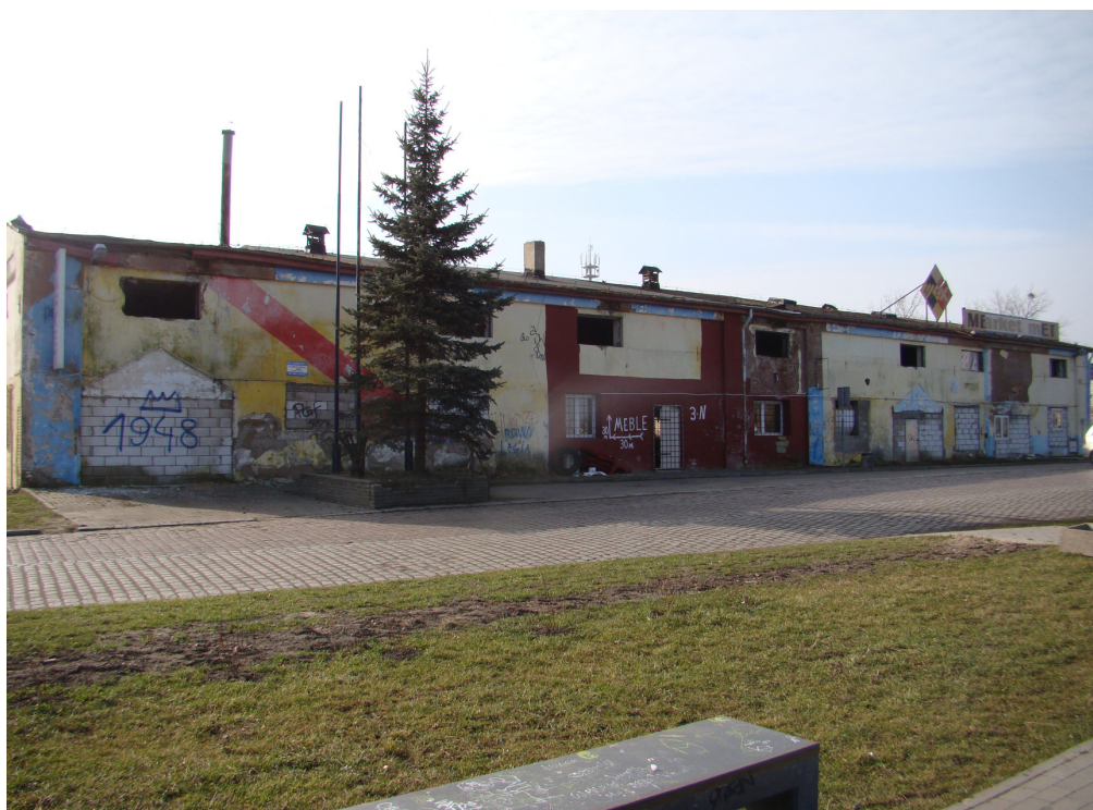
Fot. Nr1 Elewacja frontowa
