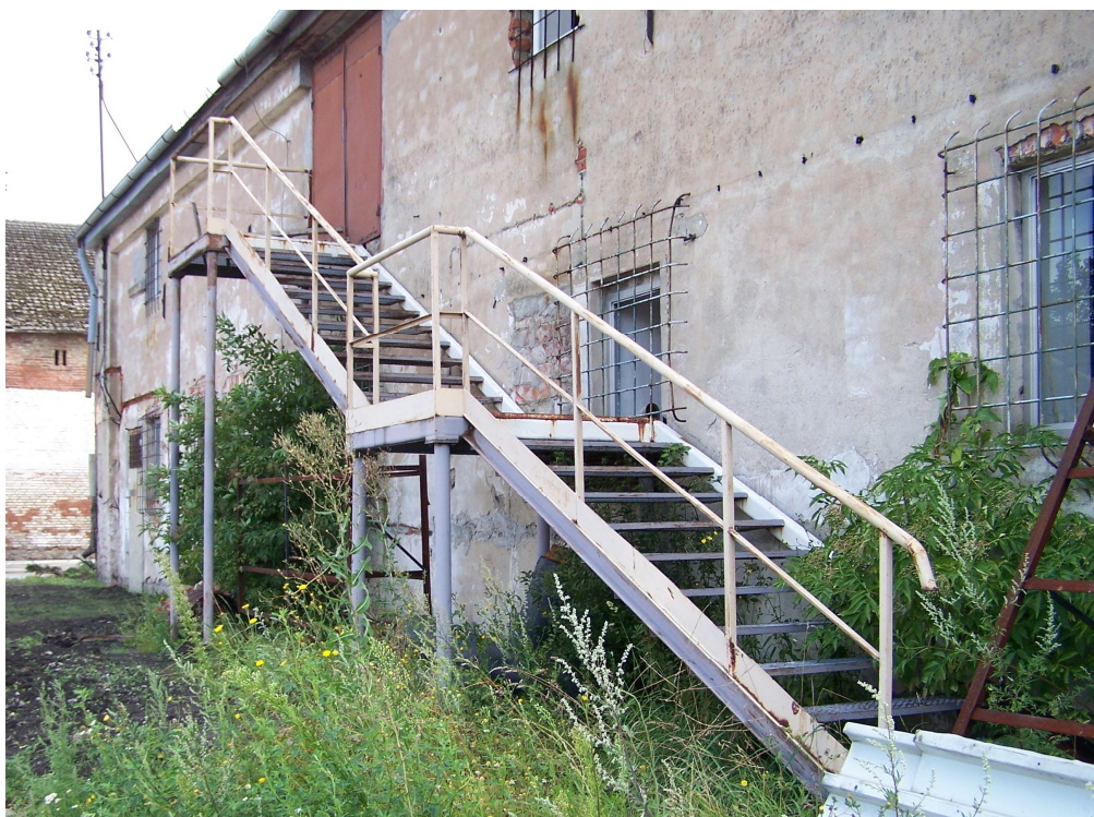
Fot. Nr11 Elewacja tylna. Schody zewnętrzne.
