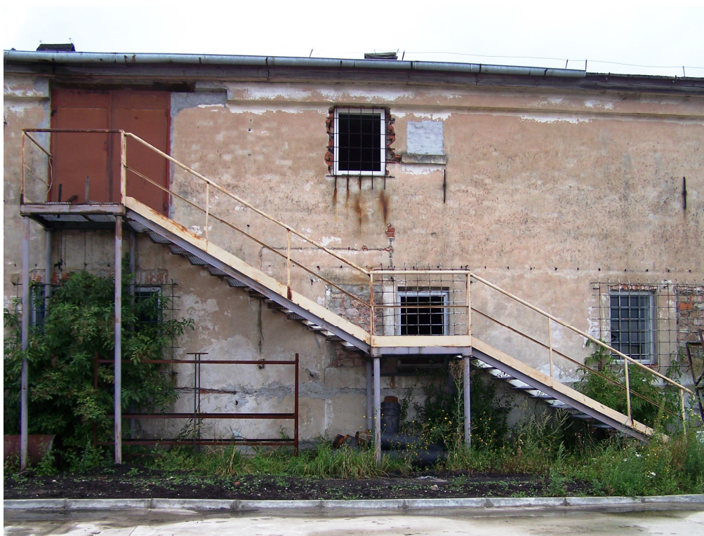
Fot. Nr12 Elewacja tylna. Schody zewnętrzne.
