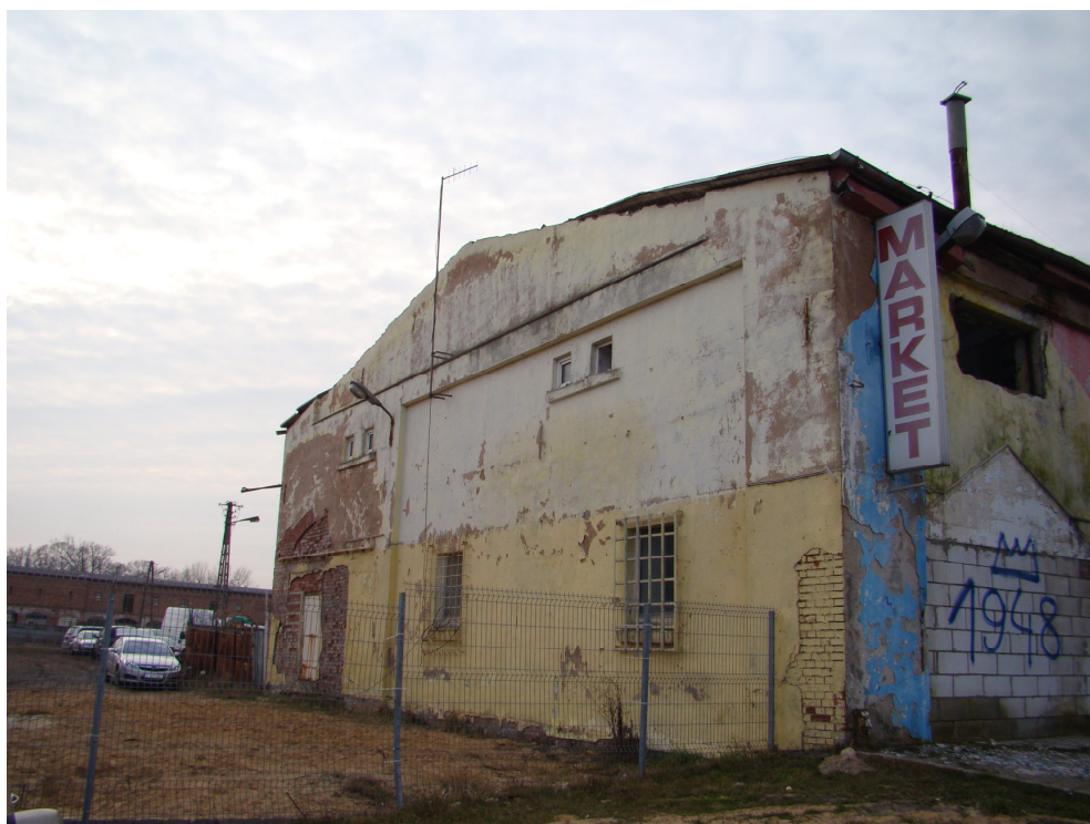
Fot. Nr3 Elewacja szczytowa
