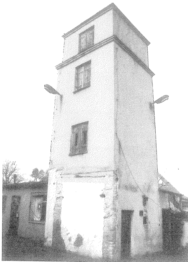
FOT. 2 Elewacja – wieża ppoż.
