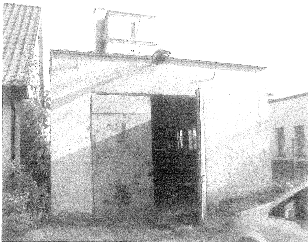
FOT. 4 Elewacja frontowa (zachodnia).
