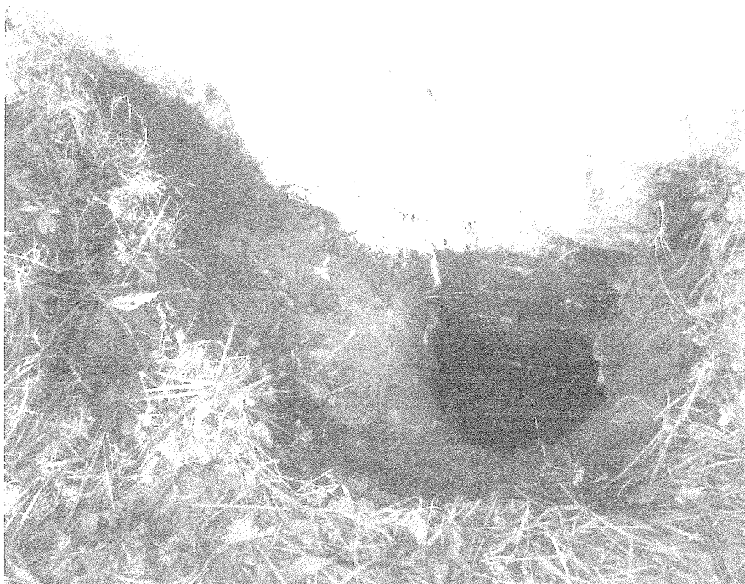
FOT. 7 Odkrywanie fundamentów pod ścianą podłużną, południową.
