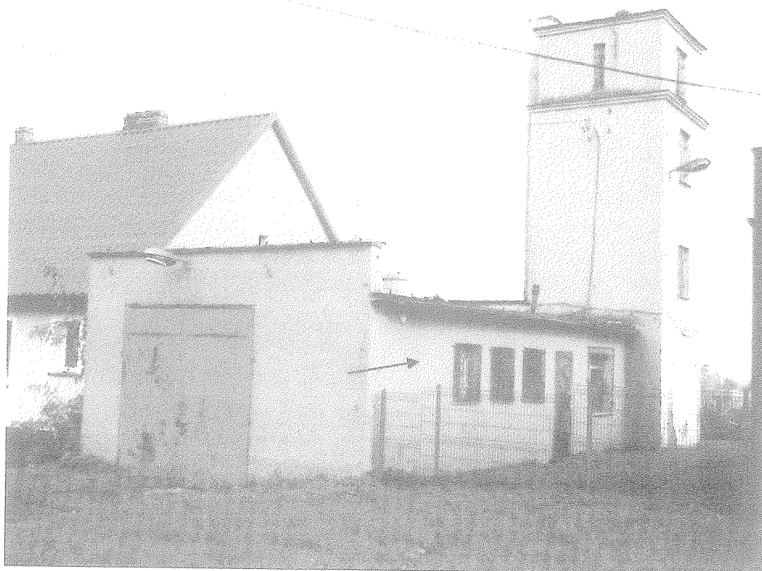
FOT. 1 Elewacja – widok ogólny.
