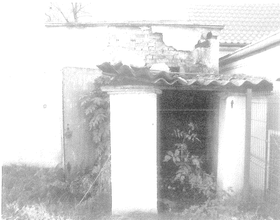
FOT. 3 Elewacja wschodnia – kotłownia.
