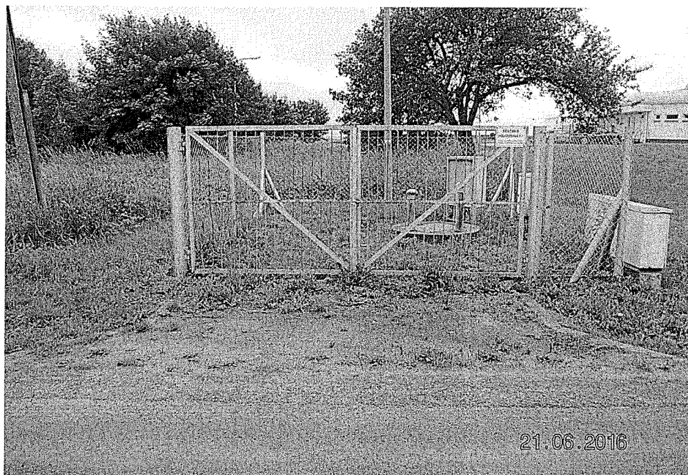
Fot. 9 Przepompownia ścieków (przewidzieć wykonanie dojazdu)
