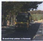
Prace przy budowie w Kołbaskowie
