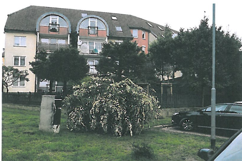
Fot. 3 Kolidująca skrzynka ZK i słup oświetleniowy.
