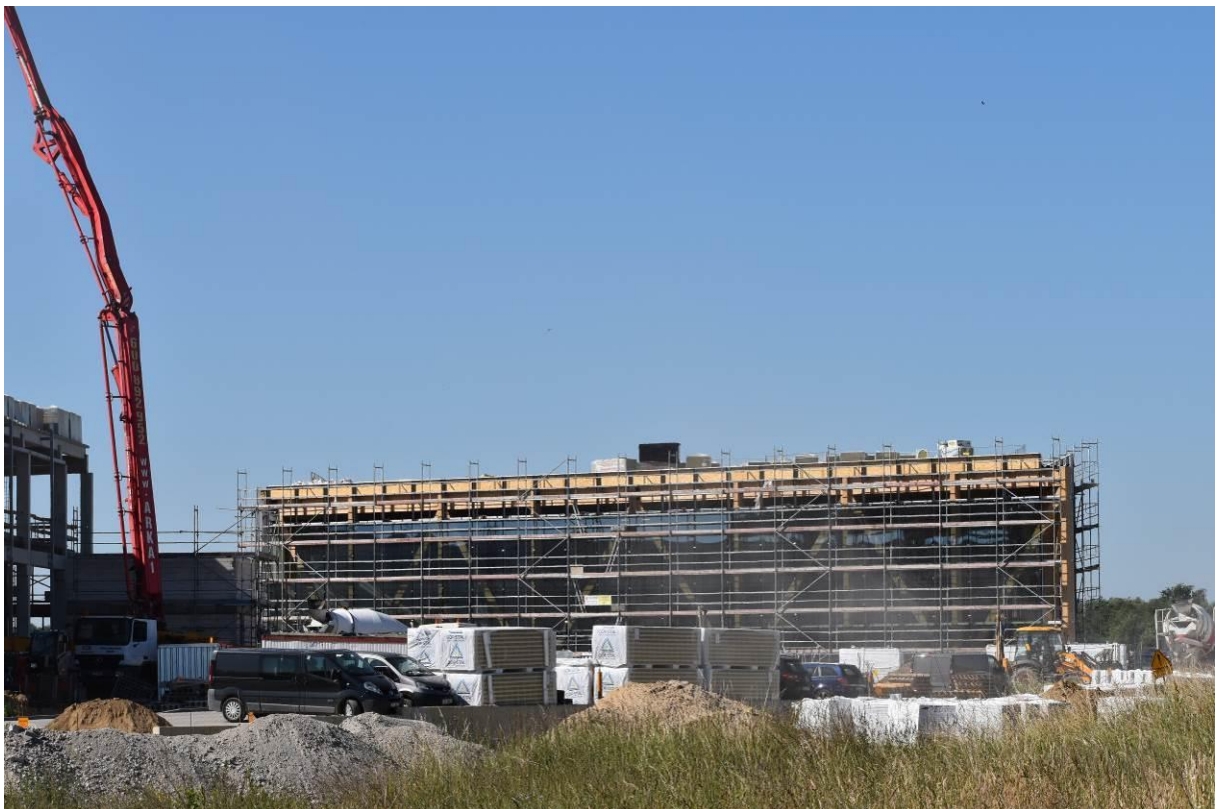
Fot. Realizowany budynek na działce nr 114/45.
