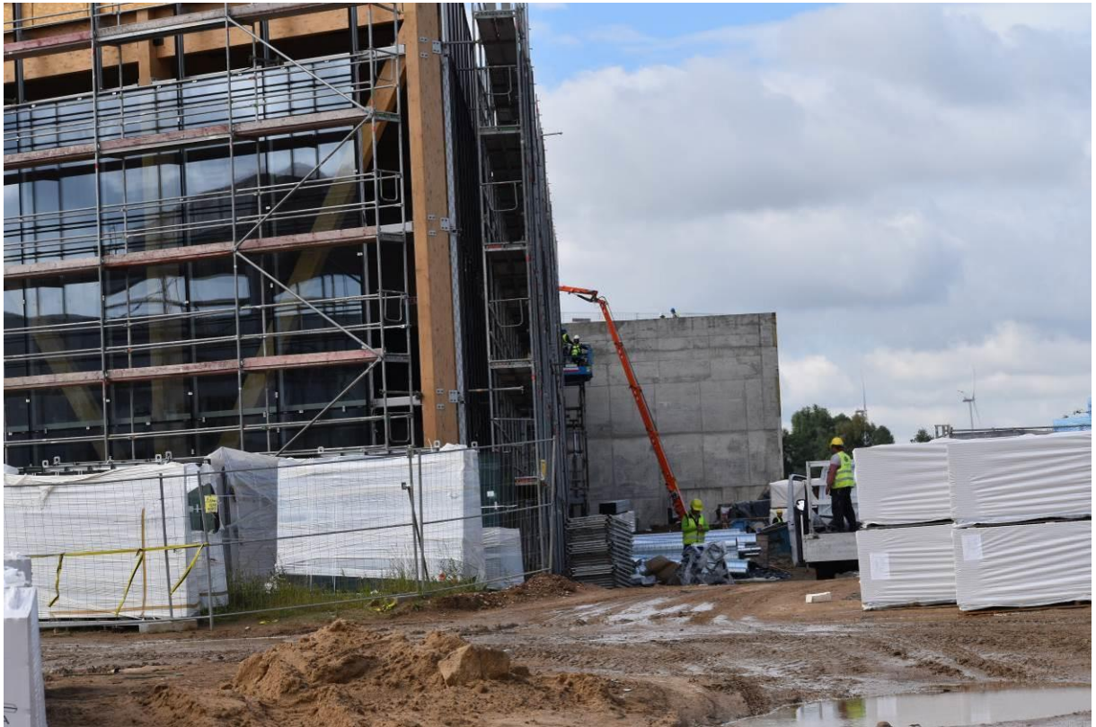
Fot. Realizowany budynek na działce nr 114/45.
