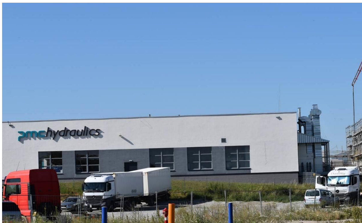
Fot. Istniejący budynek zakładu PMC na działce nr 114/10.
