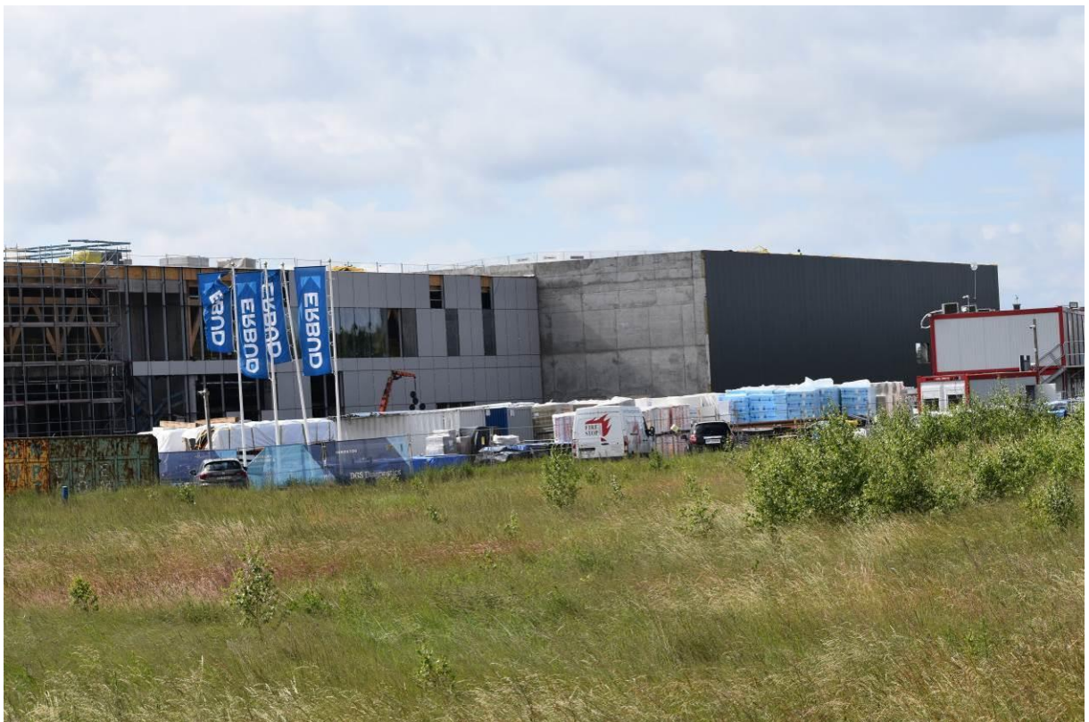
Fot. Realizowany budynek na działce nr 114/45.
