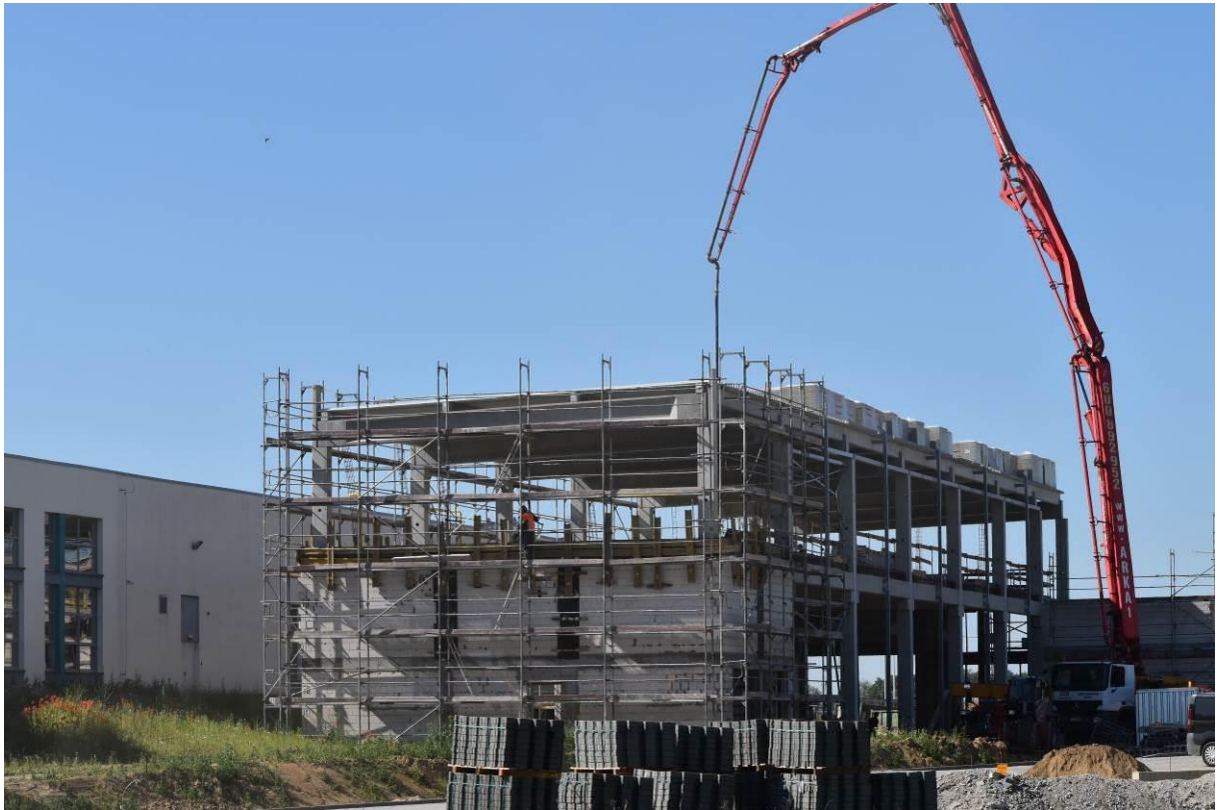
Fot. Realizowany budynek - rozbudowa zakładu PMC na działce nr 114/35.
