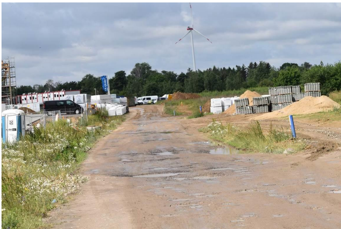
Fot. Widok na teren poza jego granicami, po stronie południowo – wschodniej (dz. nr 114/13 – droga), w tle tereny zabudowane poza granicami terenu inwestycji, po stronie południowo – zachodniej).
