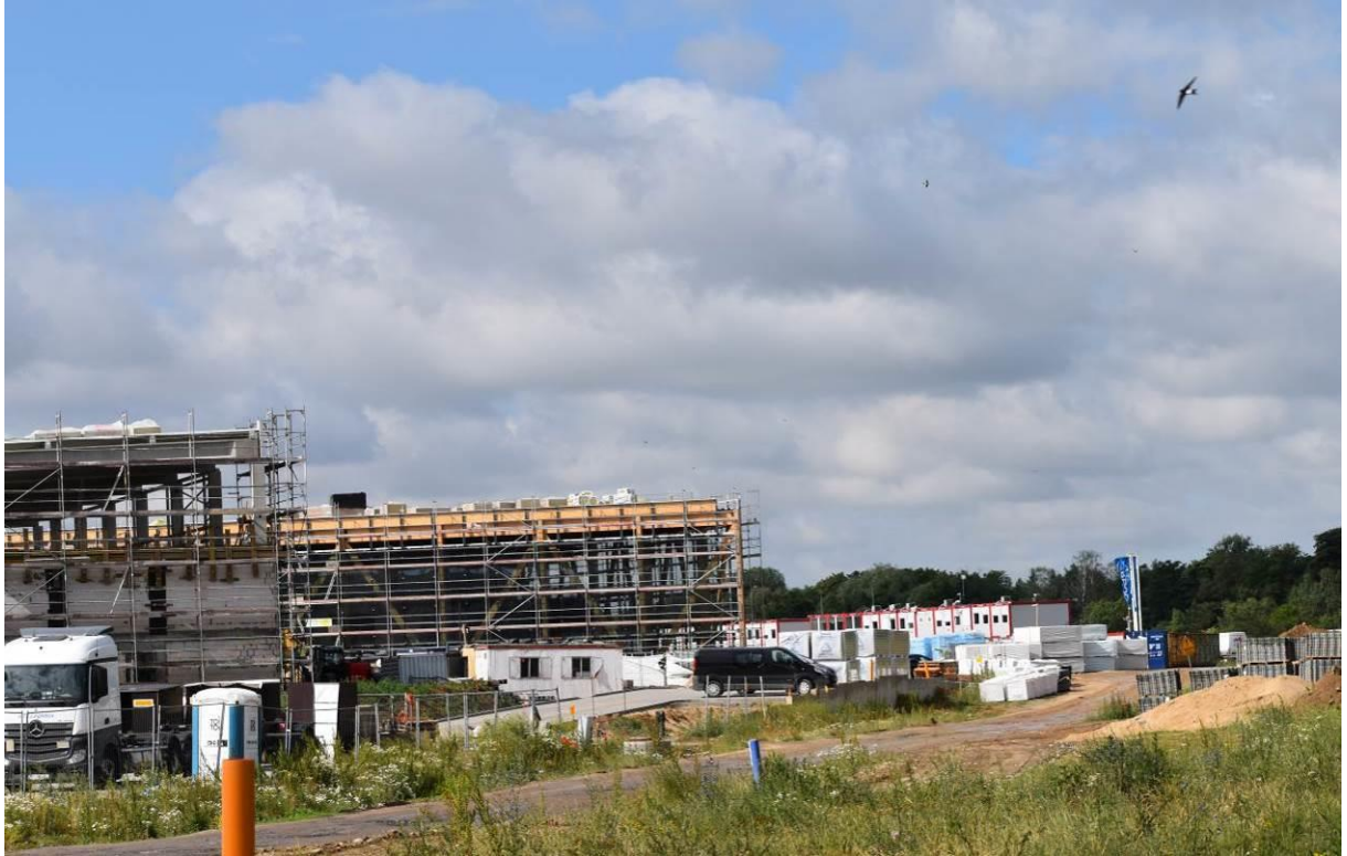
Fot. Realizowane budynki na działkach: lewy – rozbudowa zakładu PMC na działce nr 114/35, prawy – realizowany budynek na działce nr 114/45.
