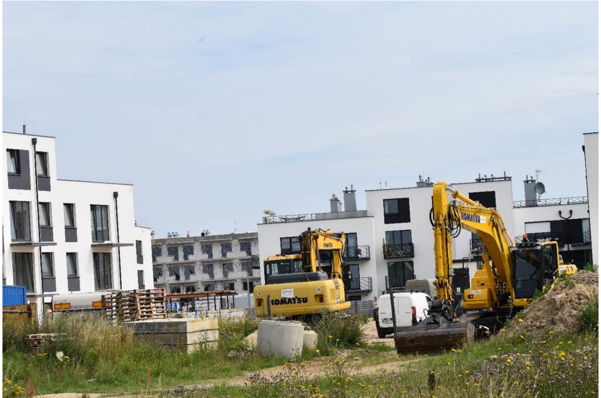
Fot. Widok na teren przedsięwzięcia – zrealizowane i realizowane budynki.
