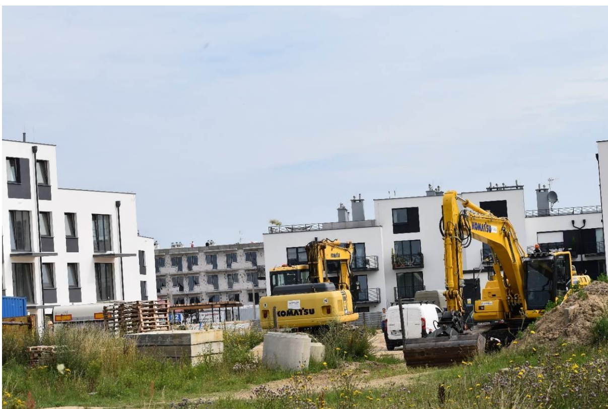
Fot. Widok na teren inwestycji – zrealizowane i realizowane budynki.
