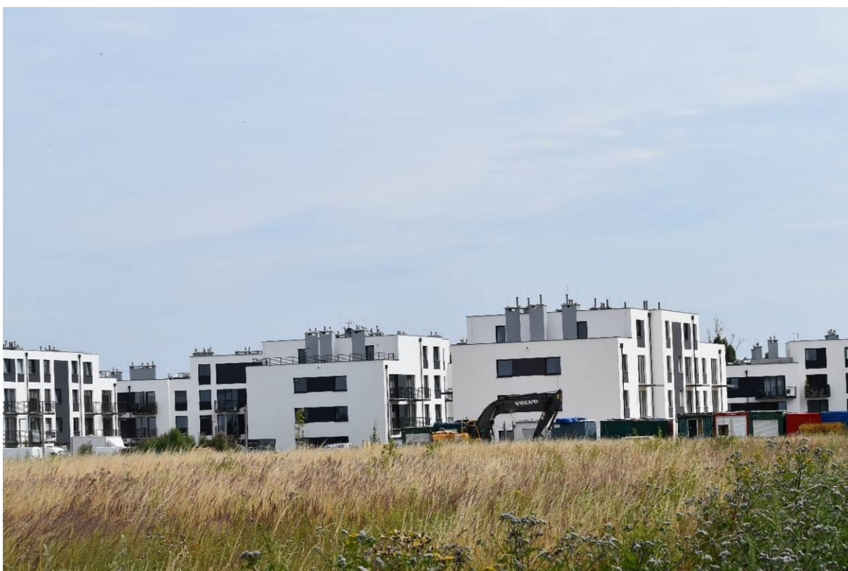
Fot. Widok na teren inwestycji – nieużytkowane grunty oraz zrealizowane budynki.
