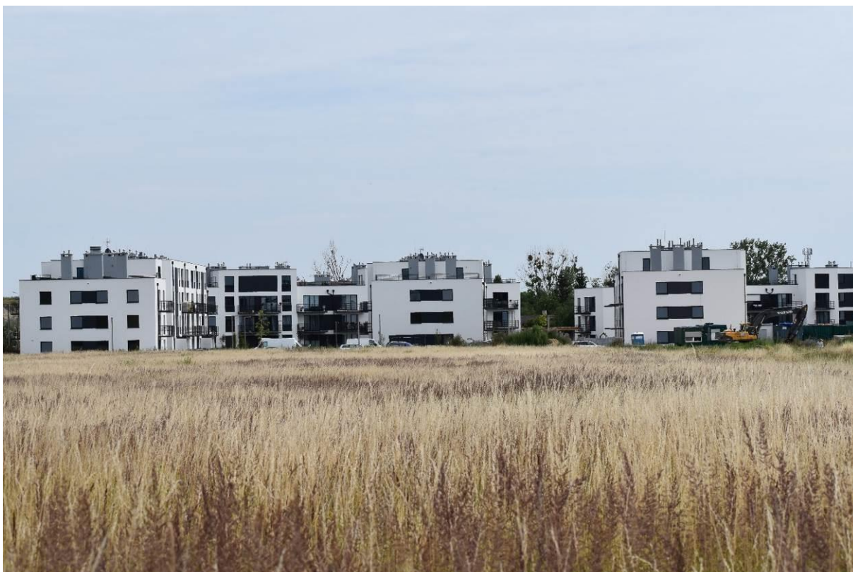
Fot. Widok na teren inwestycji – nieużytkowane grunty oraz zrealizowane budynki (w tle zadrzewienia poza granicami terenu inwestycji).
