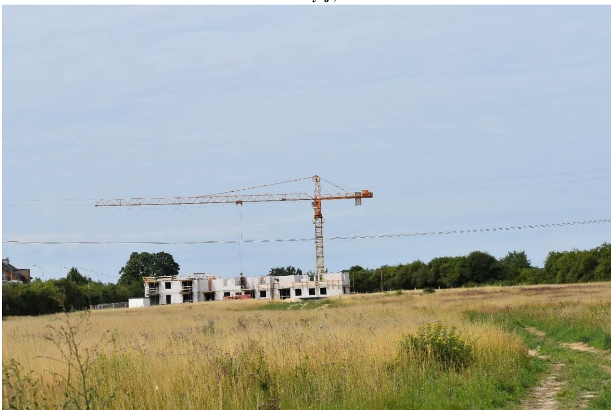
Fot. Widok na teren inwestycji – realizowany budynek oraz nieużytkowane grunty (w tle zadrzewienia poza granicami terenu inwestycji).
