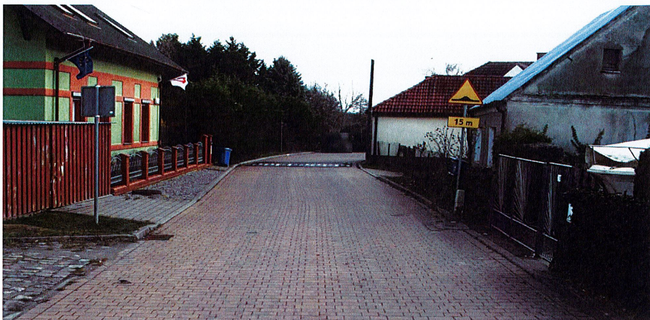
Fot. 5 Wyniesiony próg zwalniający nr 5 (w obrębie działki nr ewid. 53/1 i 44 w m. Siadło Dolne) – przeznaczony do likwidacji
