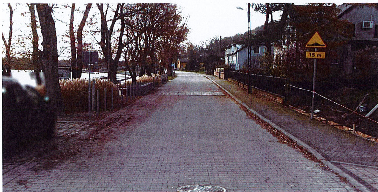
Fot. 2 Wyniesiony próg zwalniający nr 2 (w obrębie działki nr ewid. 98 w m. Siadło Dolne) – przeznaczony do likwidacji
