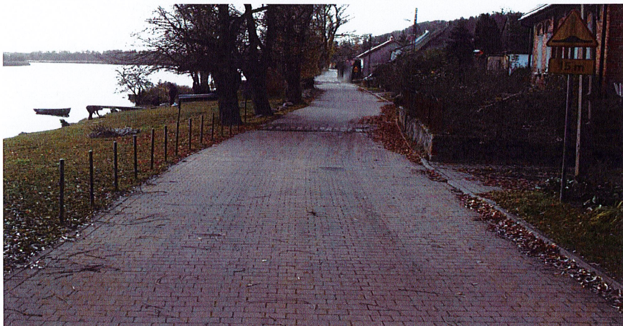
Fot. 4 Wyniesiony próg zwalniający nr 4 (w obrębie działki nr ewid. 64/2 w m. Siadło Dolne) – przeznaczony do likwidacji
