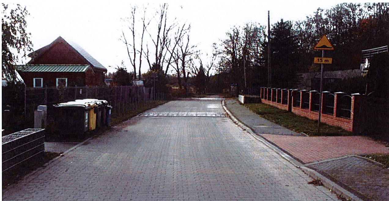
Fot. 1 Wyniesiony próg zwalniający nr 1 (w obrębie działki nr ewid. 99/8 i 79/7 w m. Siadło Dolne) –przeznaczony do likwidacji
