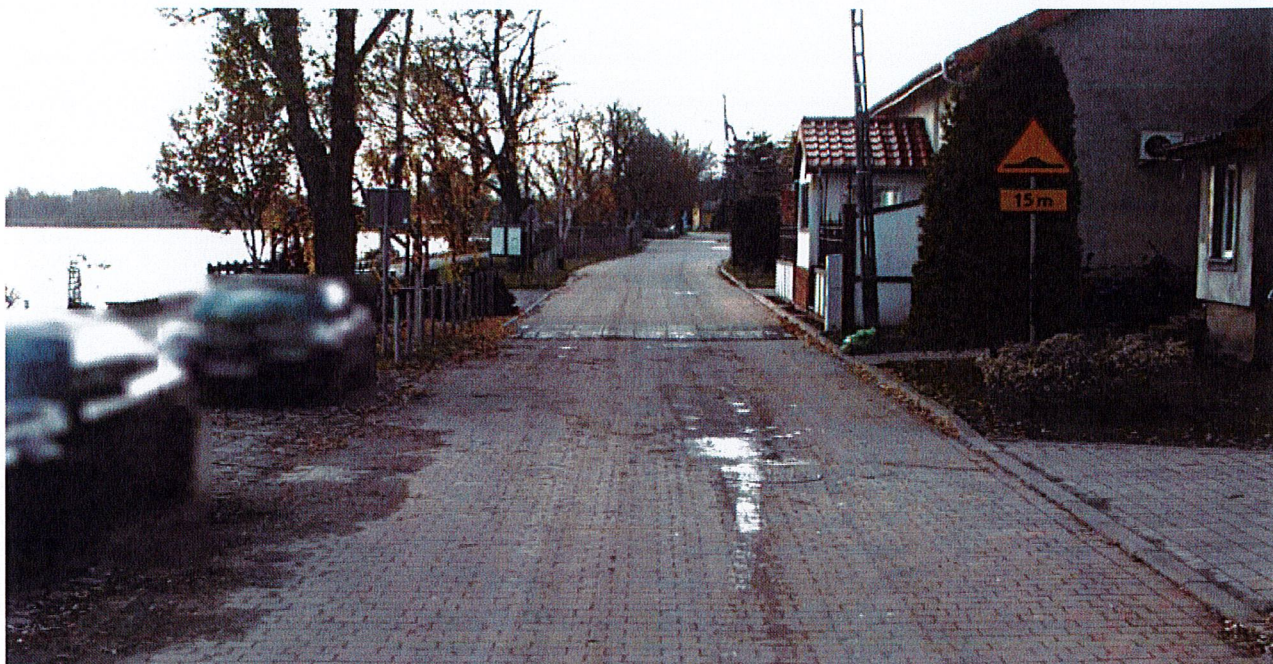
Fot. 3 Wyniesiony próg zwalniający nr 3 (w obrębie działki nr ewid. 71 w m. Siadło Dolne) – przeznaczony do likwidacji
